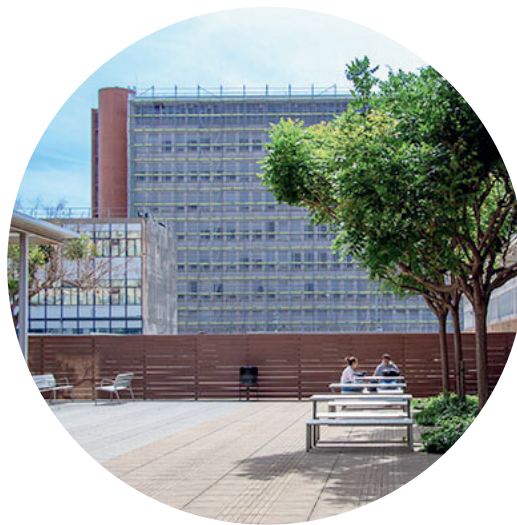
La diagnosi en clau energètica dels edificis, pilar del procés de descarbonització.
